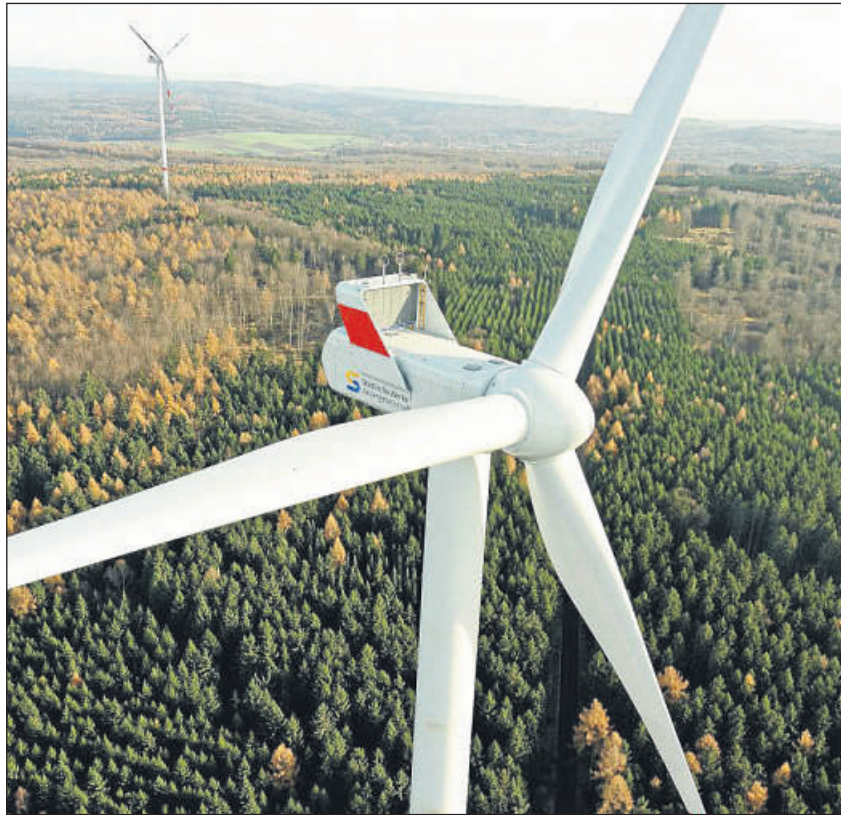
Im Nachbarland stehen sie schon: Hier der Windpark Söhrewald im hessischen Nienstetal an der Grenze zu Niedersachsen.
